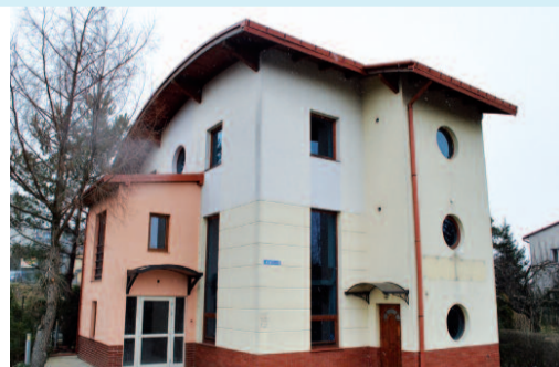
Siedziba firmy w Rzeszowie
